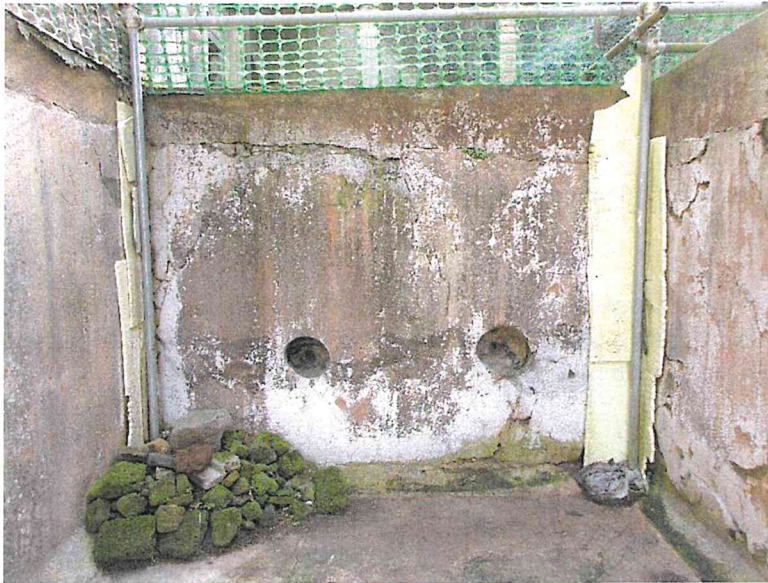
Figura 1 vasca lato Est
