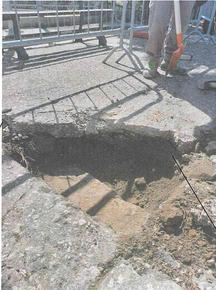
Getto di pavimentazione in cls non armato su soletta non armata
